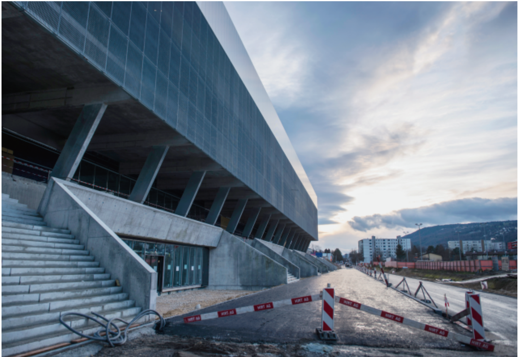
Wie die Stadien im fertigen Zustand aussehen werden, lässt sich bereits gut erahnen. Grosse Teile der Fassade sind bereits montiert worden.
